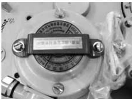
图 34 拆除压力释放阀顶部的红色横杠
